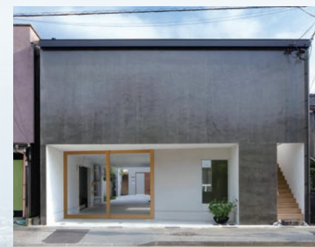
花水木ノ庭(店舗・住宅)
